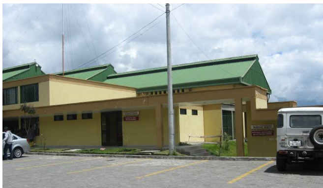
Figura. 3.9. Edificio del Camal Municipal
