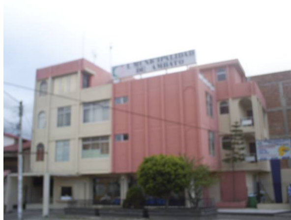
Figura. 3.7. Edificio de las Comisarias
