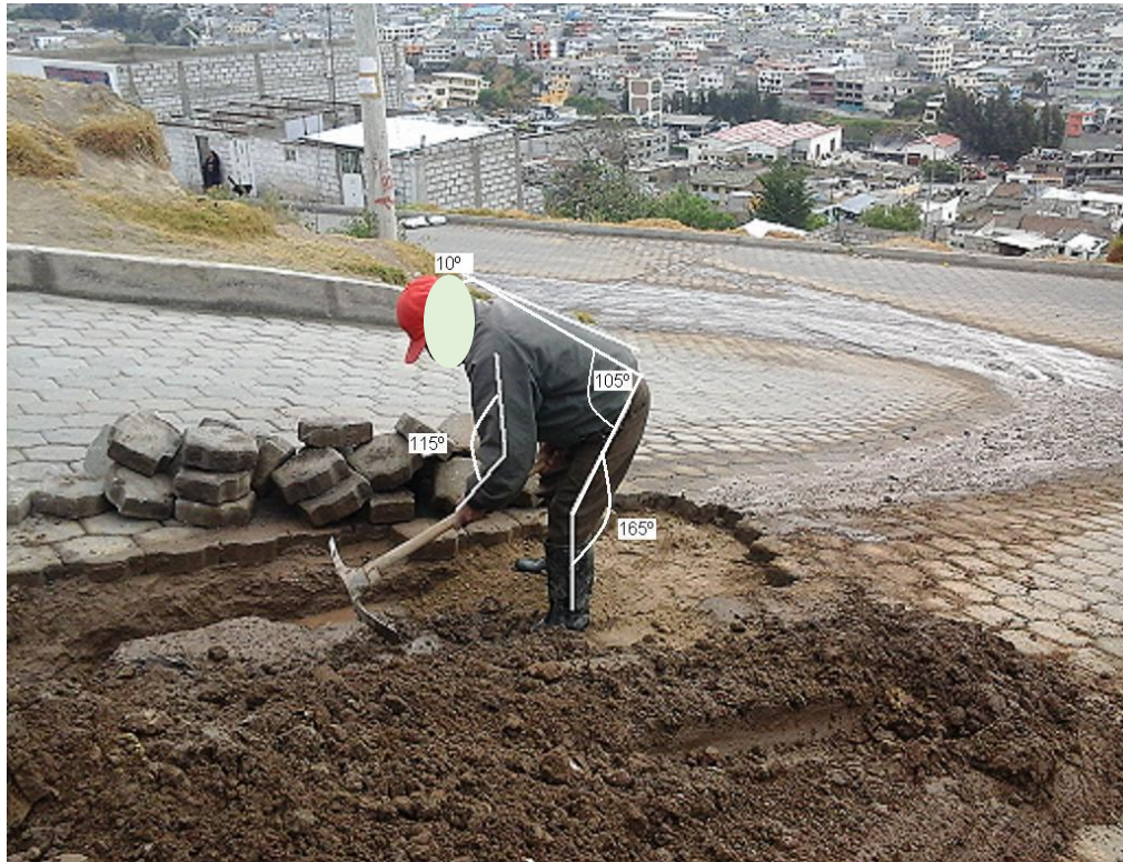
Figura Nº 4.7: Grados de inclinación en las posturas del cargo de Plomero de Agua Fuente: Carvajal, V.; León, S. (2014).
