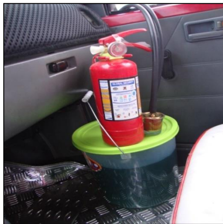
Figura 97. Extintor tipo PQS.
