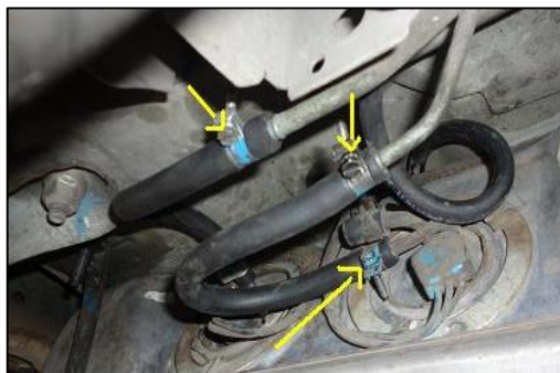
Figura 30: Líneas de combustible
