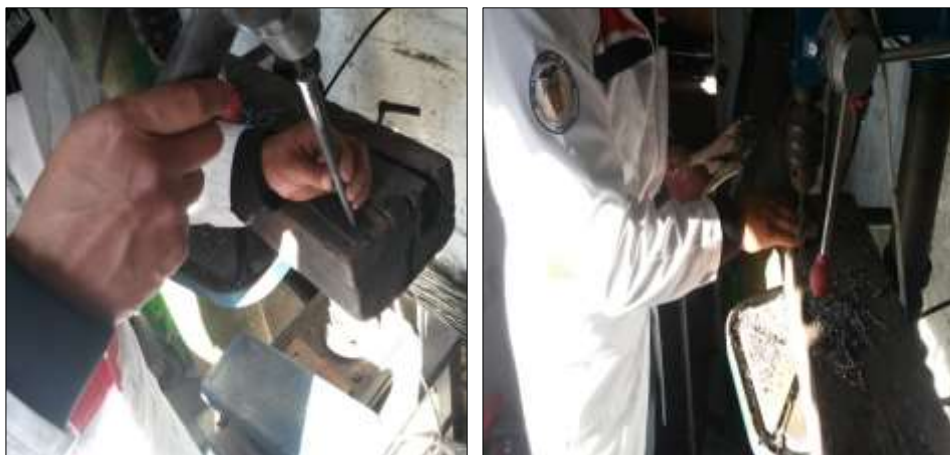
Figura 6-10: Perforación material brazos articulados
