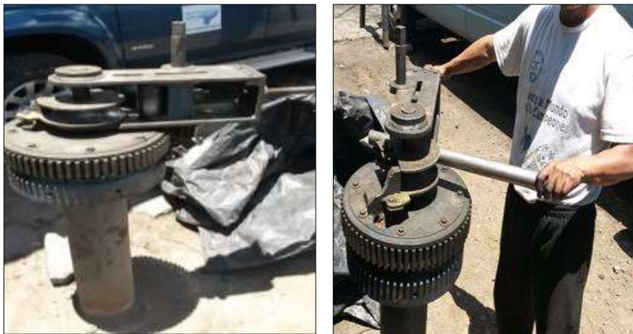
Figura 6-4: Doblado material estructural
