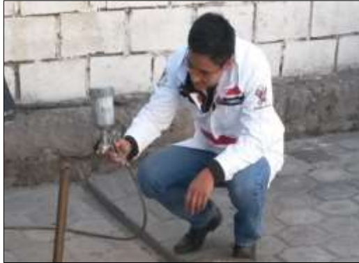
Figura 6-14: Pintura de la estructura
