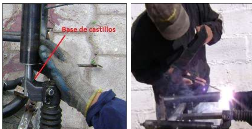
Figura 6-18: Construcción de castillos
