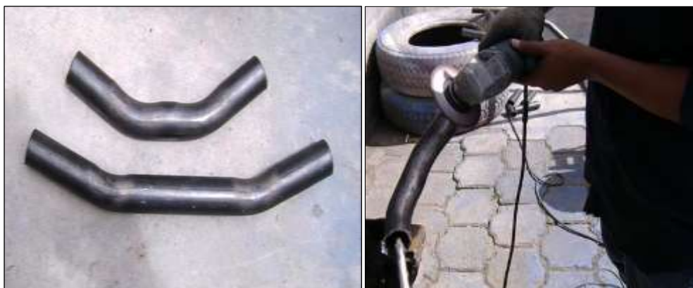
Figura 6-7: Biselado material estructural
