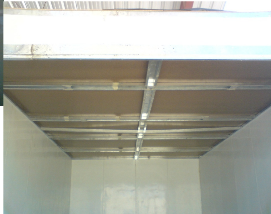
Ubicación de las planchas de aglomerado
