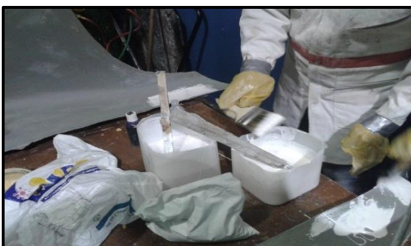
Figura 4.16 Aplicación de la resina sobre la superficie
