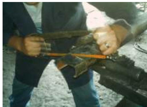
Fig. 4.7 Corte de las bases del tanque
