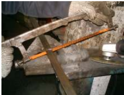
Fig. 4.3 Corte de los rieles de la bandeja
