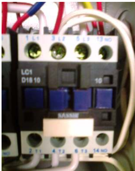
Fig. 4.25 Tercer relé de control de salida al segundo relé
