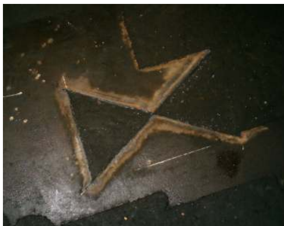
Fig. 4.1 Corte de los sujetadores de la bandeja
