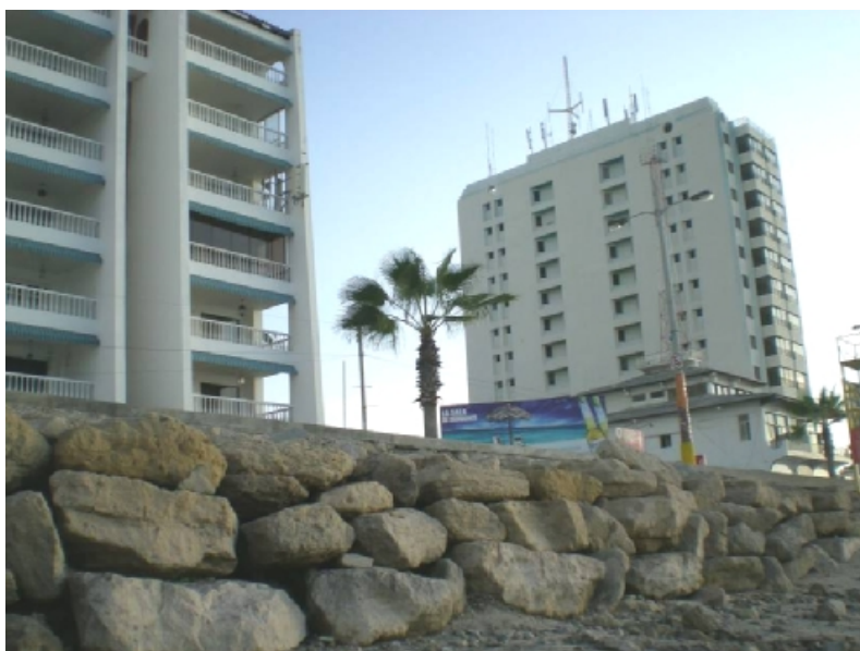
Fotografía 1.4. Muro de protección construido en el Malecón de Salinas
