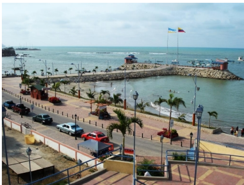
Fotografía 1.7. Obras de protección en el malecón de La Libertad
