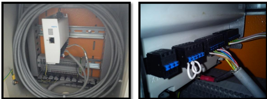
Figura 145. Proceso de Cableado de Gabinete del Controlador
