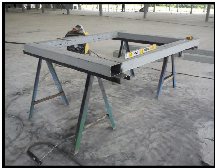
Figura 136. Armado de piezas de la estructura base
