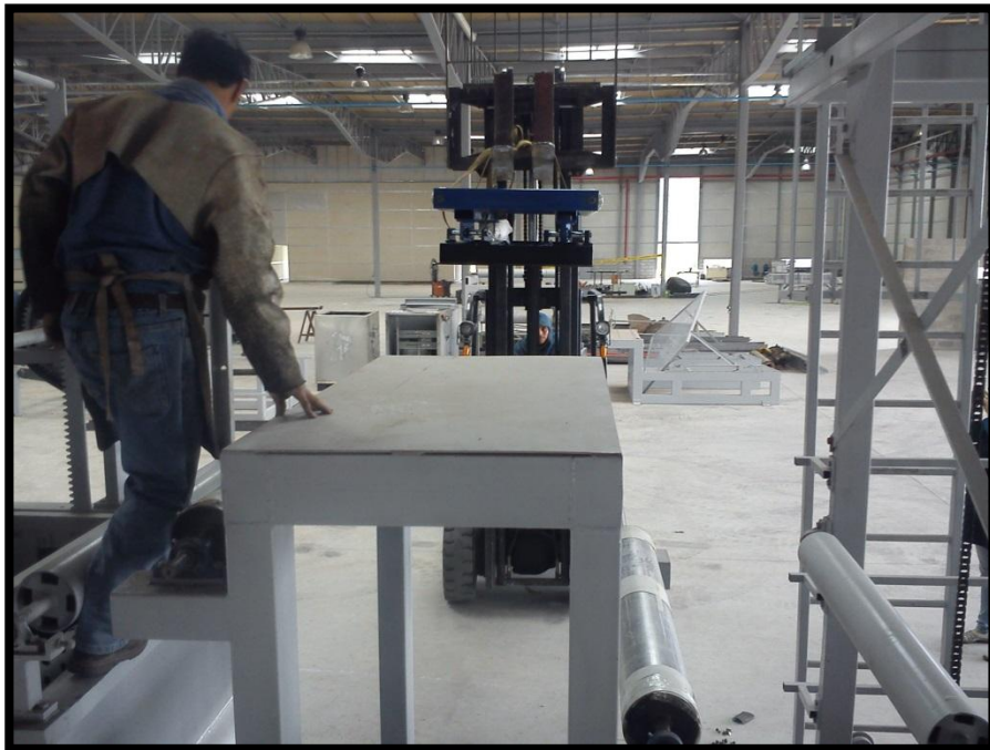
Figura 142. Posicionamiento del sistema de alineación en la estructura base.
