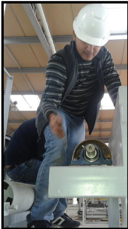
Figura 144. Colocación de rodillos de entrada/salida.
