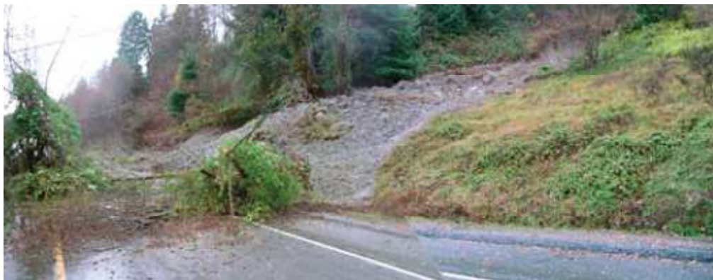
Figura 15 Flujos de Tierra en Cypress Road, West Vancouver, Canadá, 2005
