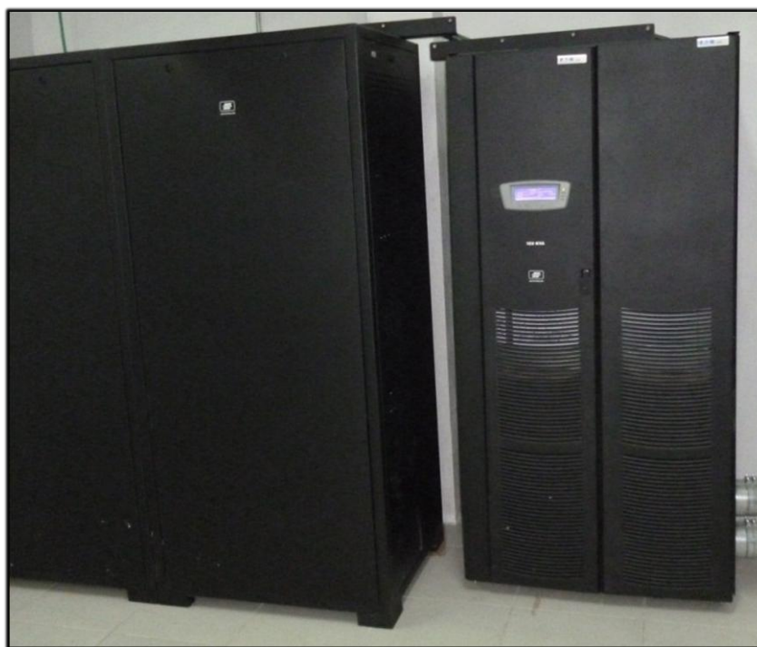
Figura 2.9: Banco de baterías FIRMESA. (Fotografía tomada en la estación de ECTV, 2013)
