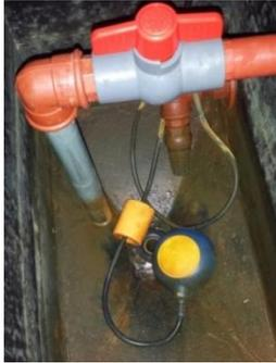
Figura 14. SISTEMA DE SEGURIDAD DE LA BOMBA
