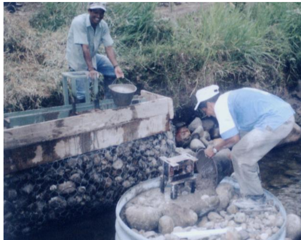
Figura 4.17 Construcción de las bases de hormigón
