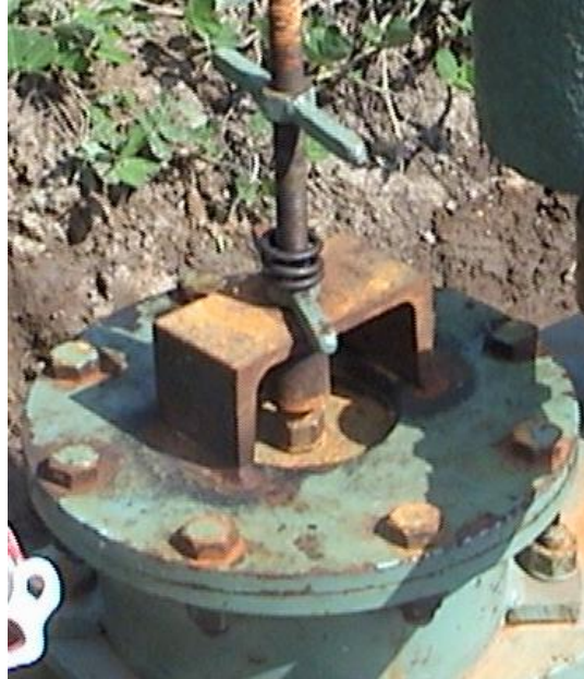
Figura 5.10 Válvula de impulsión.
