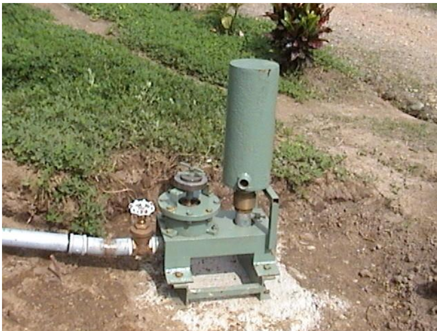
Figura 5.13 Instalación del ariete (2).
