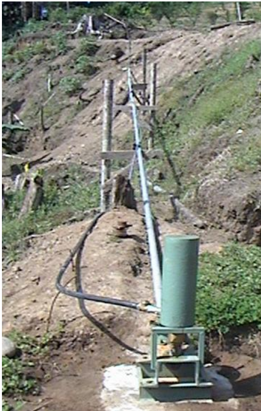
Figura 5.12 Instalación del ariete (1).
