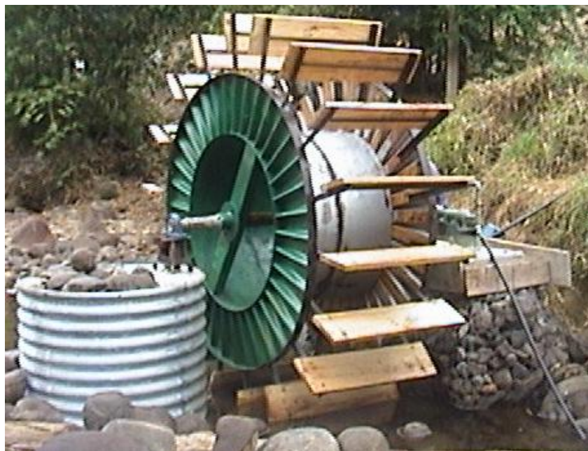
Figura 4.20 Montaje de la rueda y conexiones finales
