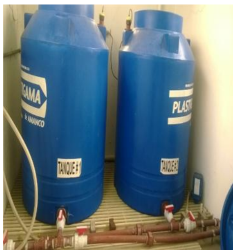
Figura 42. Sistema de dosificación con Hipoclorito de Sodio.
