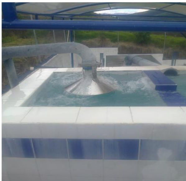
Figura 35. Desarenador
