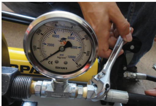
Figura 87. Colocación de la manguera en el cilindro
