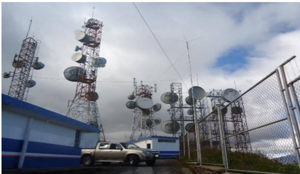
Figura No. 3.9 Infraestructura externa existente Estación Repetidora Cerro Blanco
