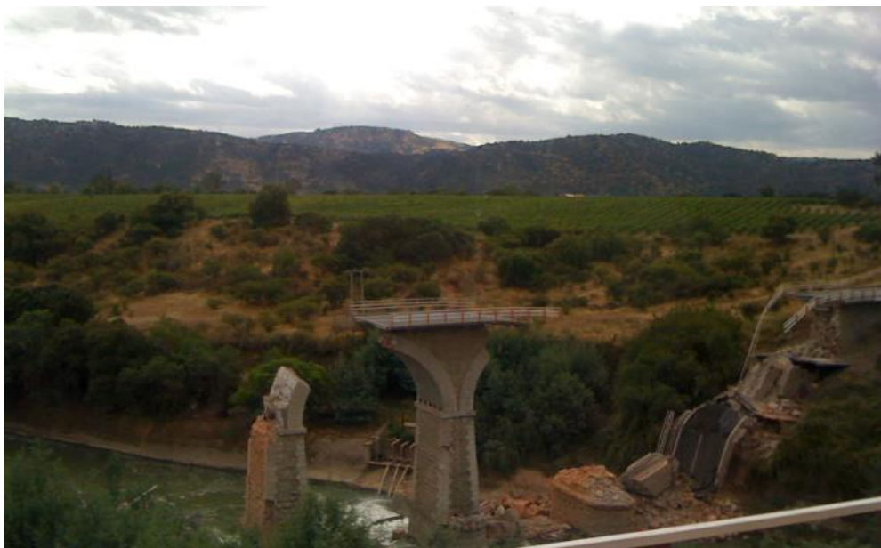
Figura No. 1.3 Puente sobre el río Claro ciudad Camarico sur de Santiago de Chile
