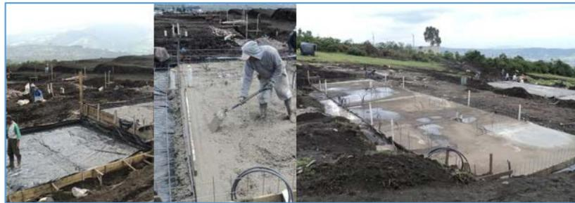
Figura 74 Fundición del contrapiso
