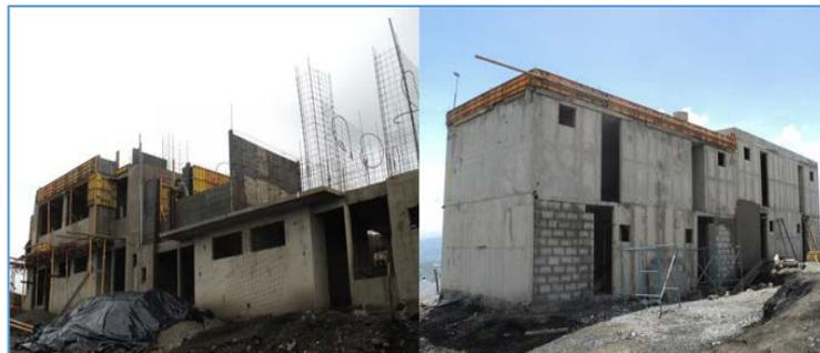
Figura 78 Armado primer piso
