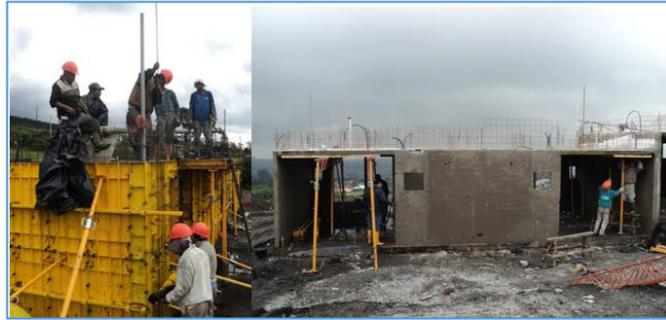
Figura 77 Fundición y desencofrada planta baja
