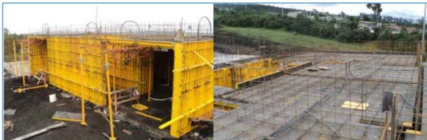
Figura 76 Preparación de formaletas de la losa
