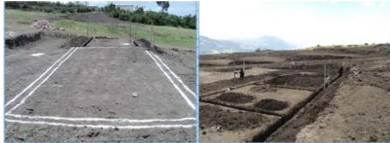
Figura 71 Replanteo y excavación
