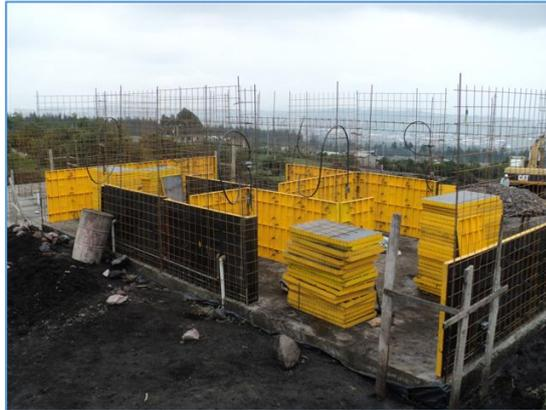
Figura 75 Armado de formaletas planta baja
