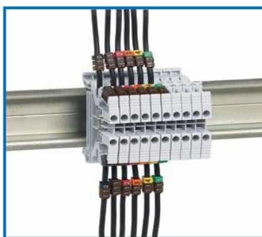
Figura 62. Clemas para la interconexión de cables
