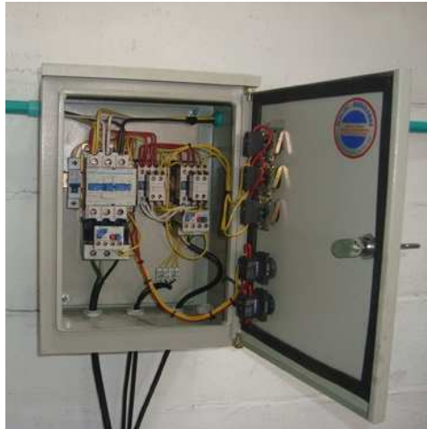
Figura 10 Montaje de Gabinete eléctrico
