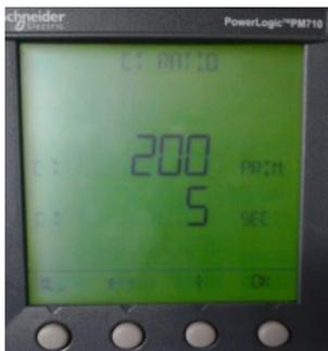
Figura 2. 18 Configuración de CT
