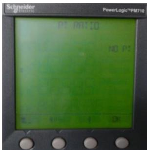
Figura 2. 19 Configuración de PT
