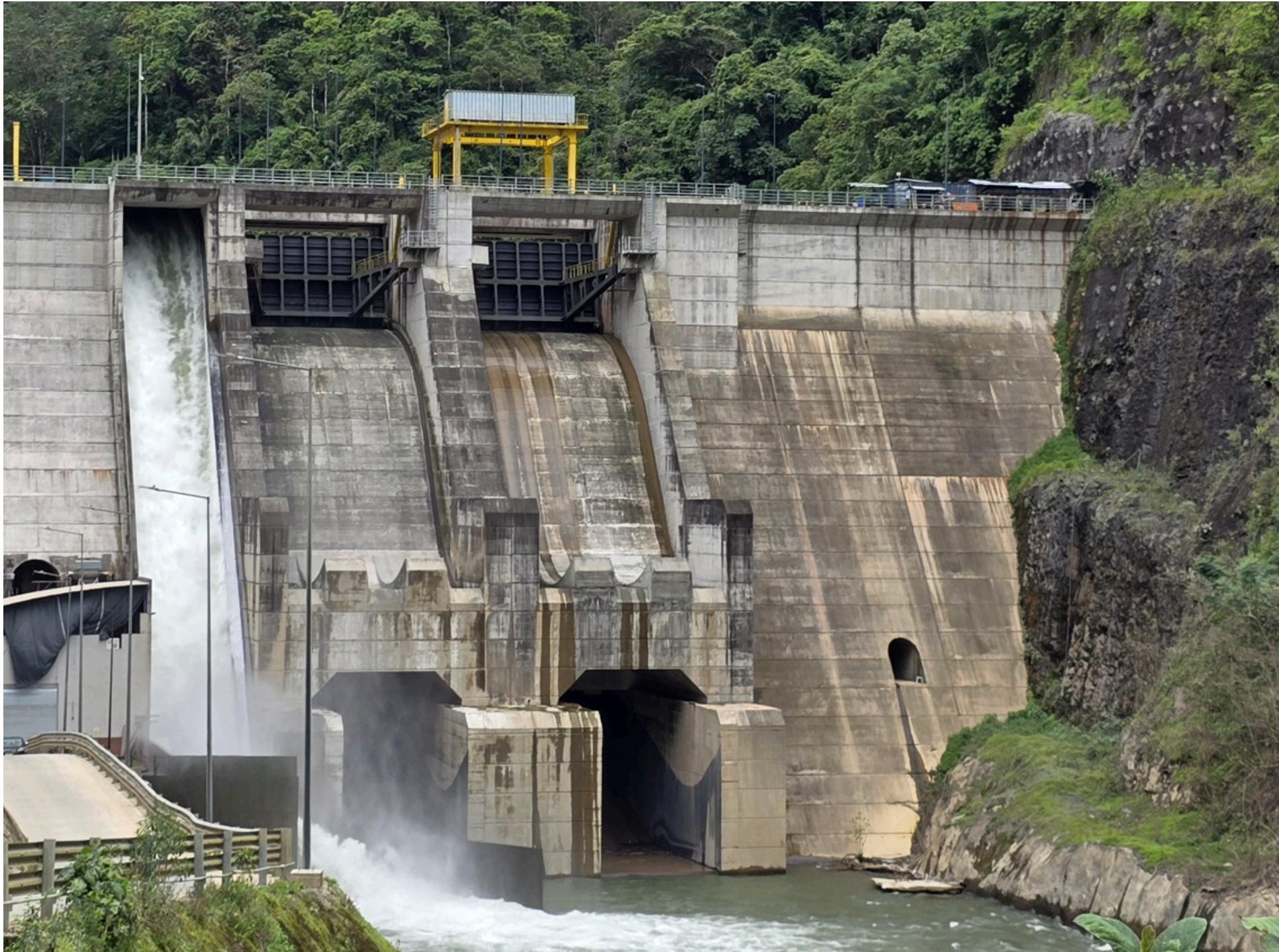
Coordenadas UTM de la Presa Toachi Este 731,98 Norte 9'959.340
